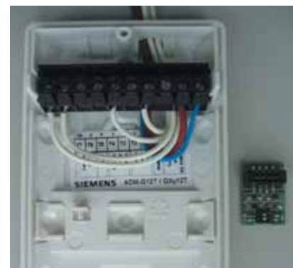
Típico cableado simple de E-Line
